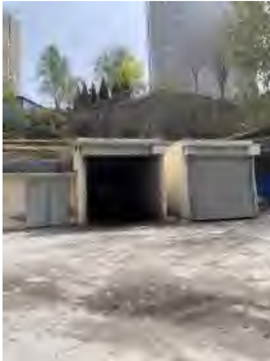
一般固废、生活垃圾房
